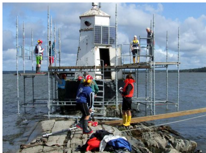
Röskärs fyr, Snappudden nedre, under renovering i september 2011.
